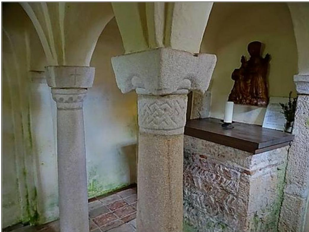
Abb. 44: Foto der romanischen Hallenkrypta mit Blickrichtung nach Osten, wo sich der aus Ziegeln gemauerte Altartisch befindet. Davor zwei schlanke, aus hellem Marmor gefertigte runde Stützen die, mittels der ausladenden Kämpfer der Kapitelle, die Kreuzgratgewölbe tragen. Quelle: R. S. Zappe, 2021.
