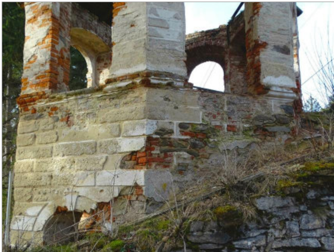
Abb. 5.54: Zustand der Teufelskirche im Mai 2023 (Aufgang im Osten). Quelle: R. Zappe, 2023.
