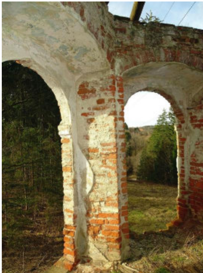
Abb. 5.58: Zustand der Teufelskirche im Mai 2023 (Innenansicht eines Mauerwerkdetails). Quelle: R. Zappe, 2023.
