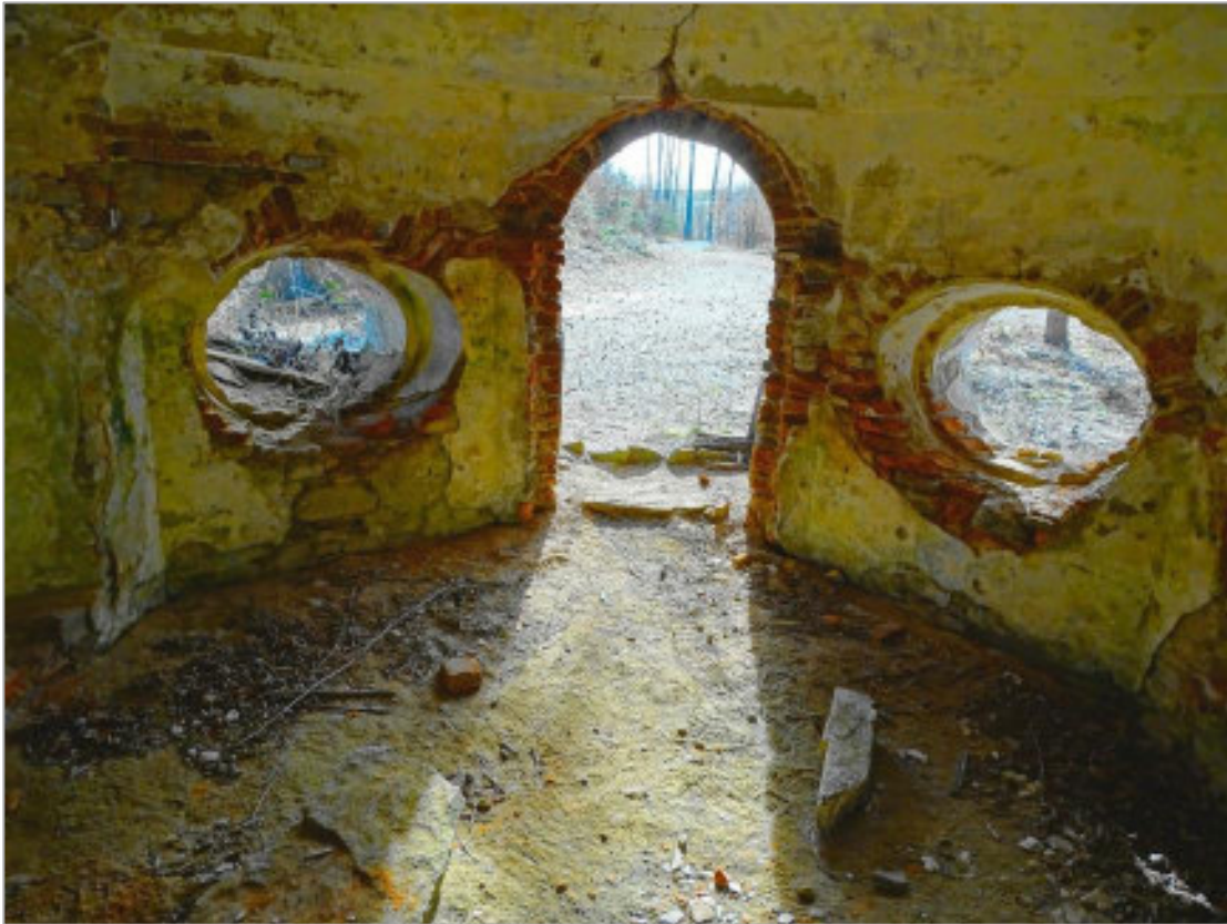
Abb. 5.49: Zustand der Teufelskirche im Mai 2023 (EG-Innenansicht nach Süden). Quelle: R. Zappe, 2023.
