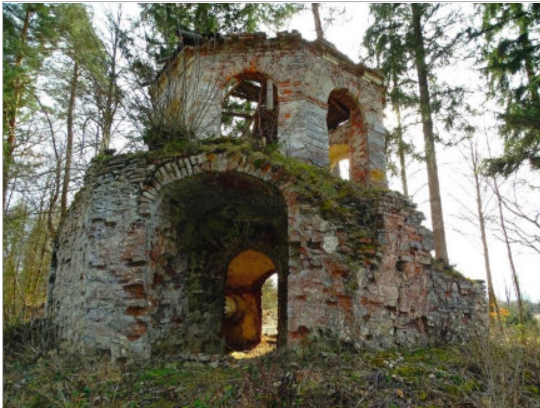
Abb. 5.47: Zustand der Teufelskirche im Mai 2023 (Nord-Ansicht). Quelle: R. Zappe, 2023.
