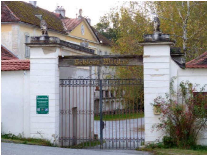
Abb. 5.16: Ansicht des Haupttores von Osten aus. Quelle: Christa Posch.
