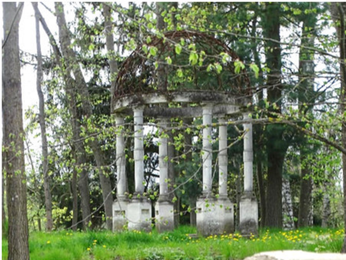
Abb. 5.25: Runder, steinerner Gartentempel in der Süd-Ost-Ecke des Schlossparks, etwa 142 m vom Haupttrakt entfernt innerhalb einer Baum- und Sträuchergruppe und etwa 2 m erhöht gelegen. Quelle: R. Zappe, 2023.
