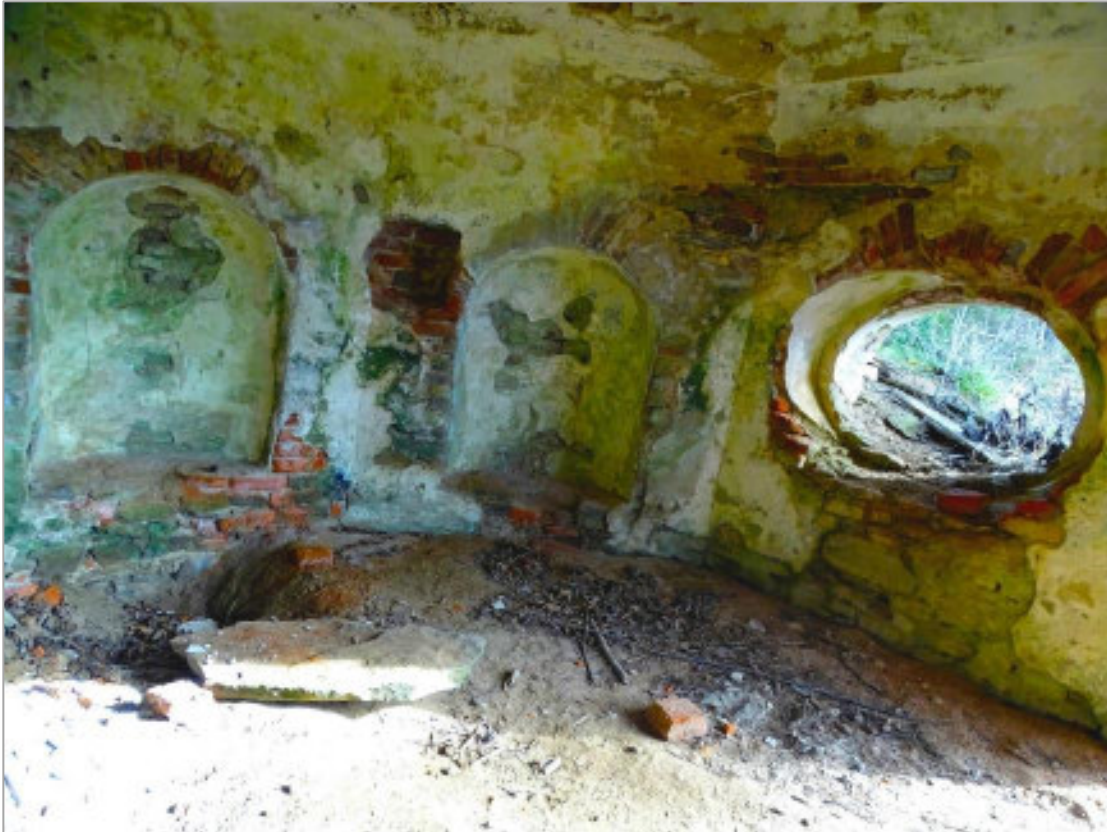
Abb. 5.50: Zustand der Teufelskirche im Mai 2023 (EG-Innenansicht nach Osten). Quelle: R. Zappe, 2023.
