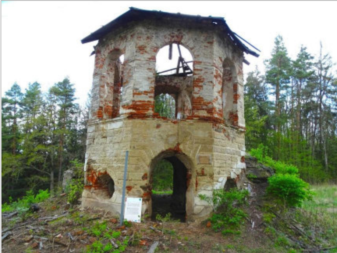
Abb. 5.45: Zustand der Teufelskirche im Mai 2023 (Süd-Ansicht). Quelle: R. Zappe, 2023.
