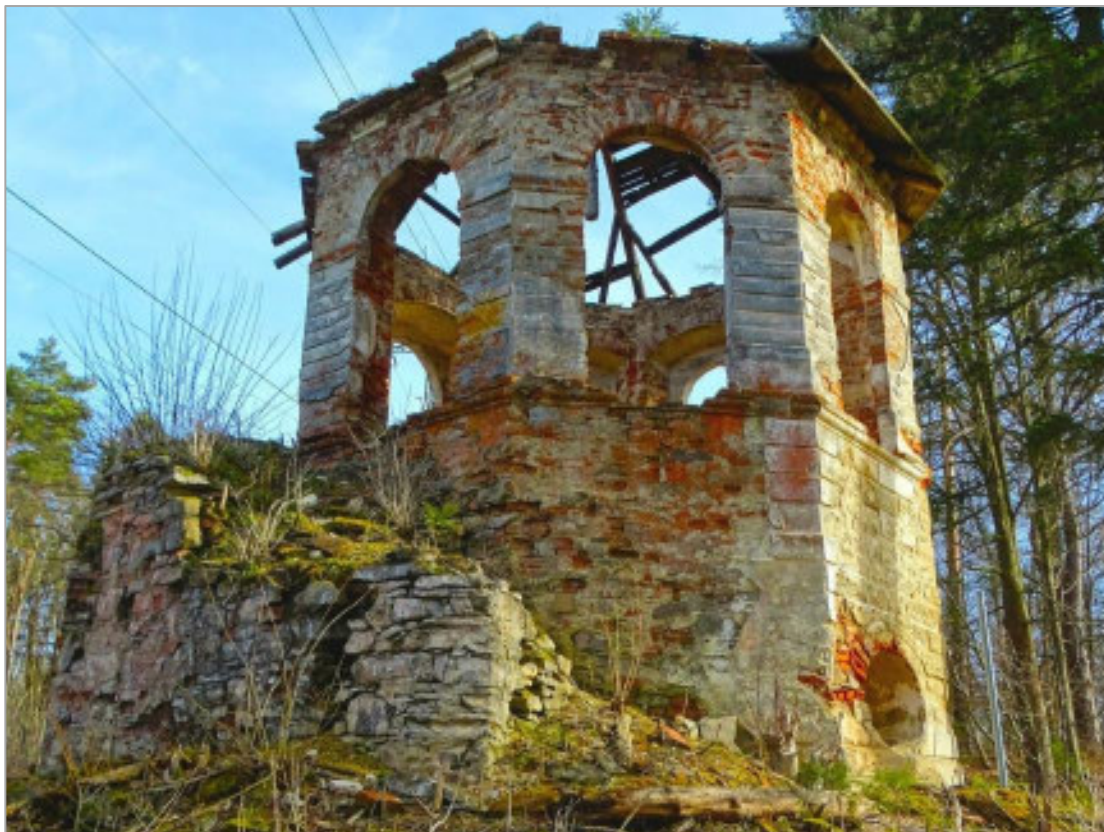
Abb. 5.48: Zustand der Teufelskirche im Mai 2023 (West-Ansicht). Quelle: R. Zappe, 2023.
