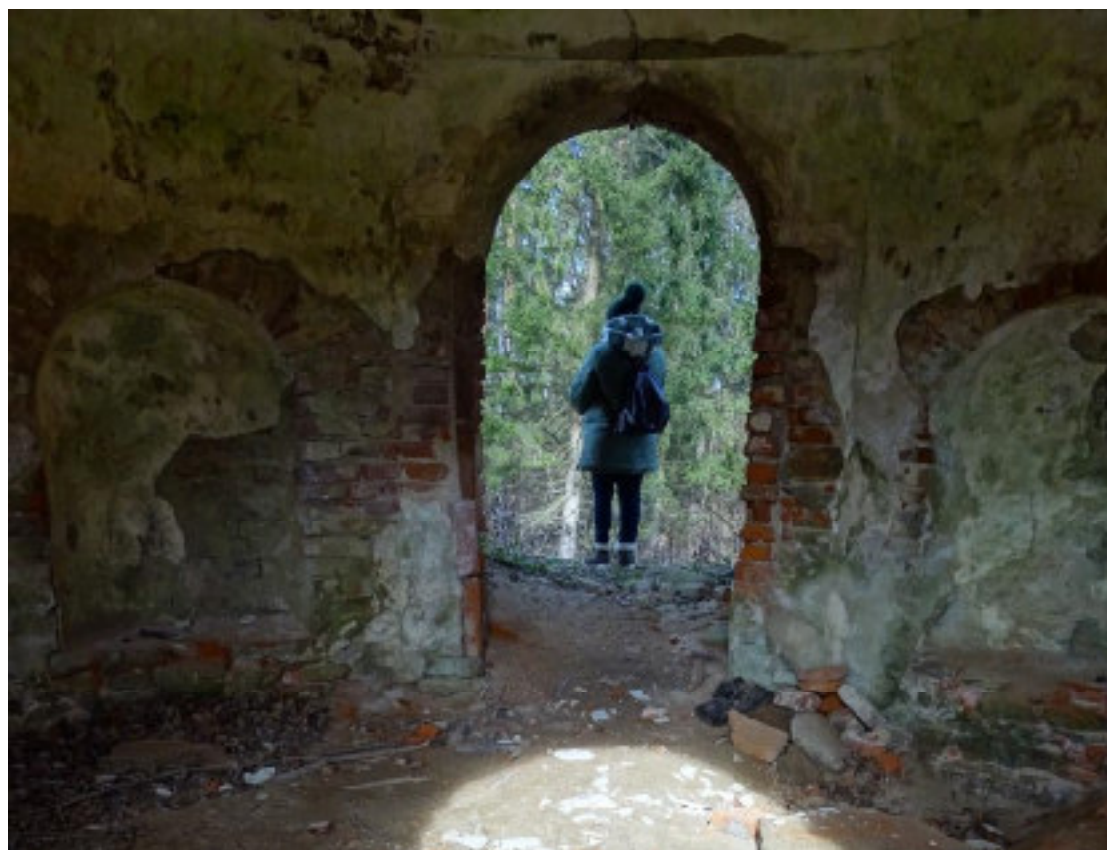
Abb. 5.52: Zustand der Teufelskirche im Mai 2023 (Süd-Ansicht). Quelle: R. Zappe, 2023.
