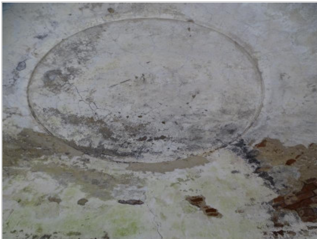
Abb. 5.51: Zustand der Teufelskirche im Mai 2023 (EG-Innenansicht der Gewölbedecke). Quelle: R. Zappe, 2023.
