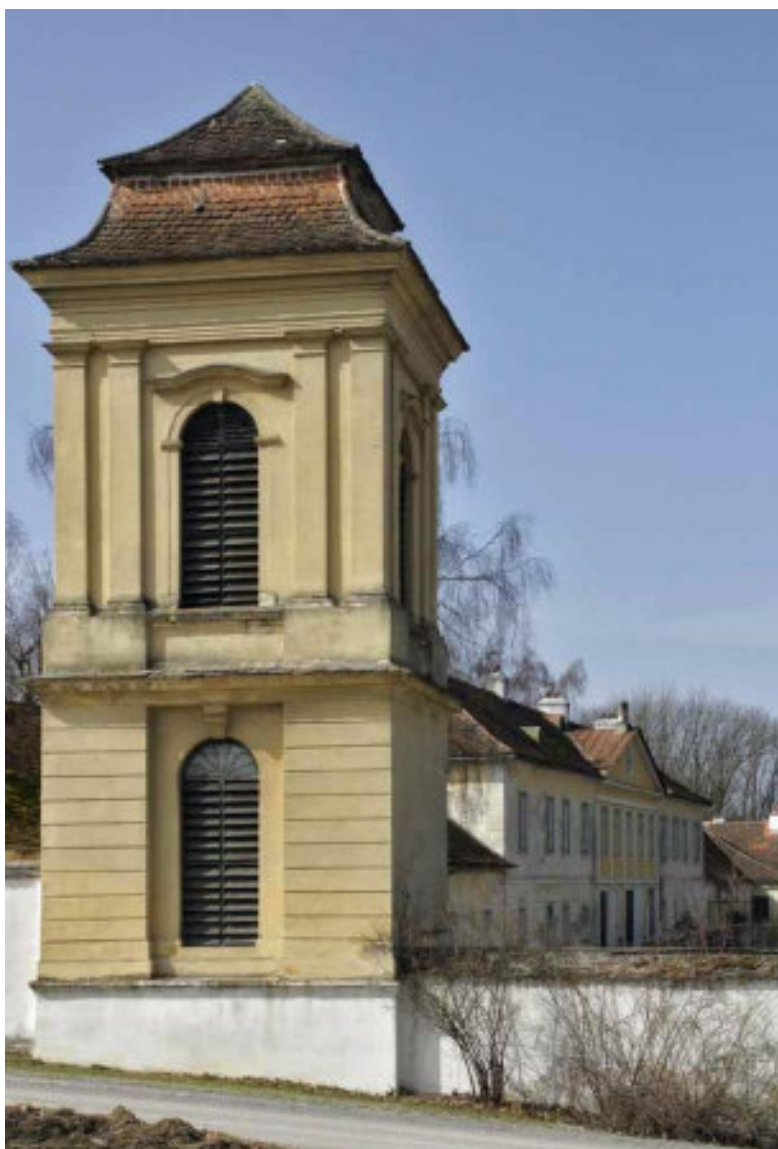
Abb. 5.17: Ansicht der Ostseite des astronomischen Turms der an den Haupttrakt und das Schlosstor angrenzt. Quelle: Johannes Ebner.
