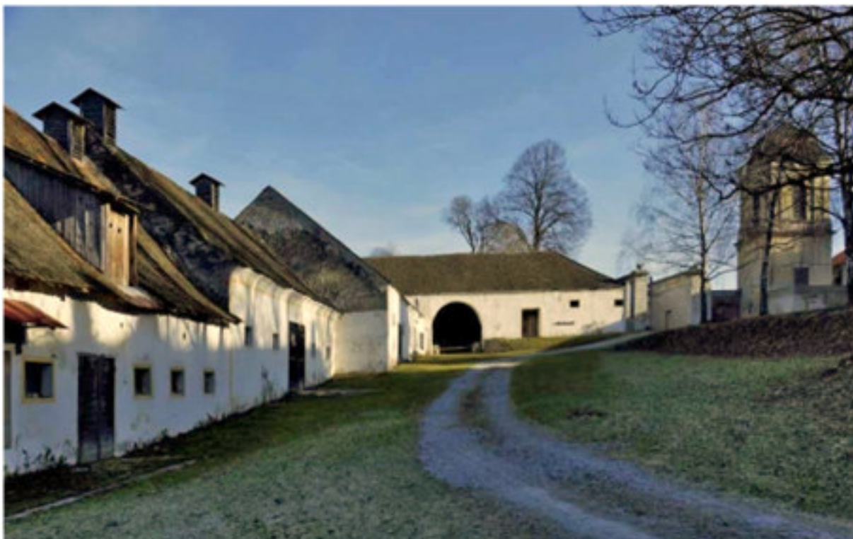
Abb. 5.15: Ansicht der im Norden und Osten stehenden Wirtschaftsgebäude (inkl. Schlosszufahrt und Astronomischem Turm) Quelle: Johannes Ebner.
